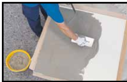
Двойное нанесение (обратная сторона плиты KERLITE)
