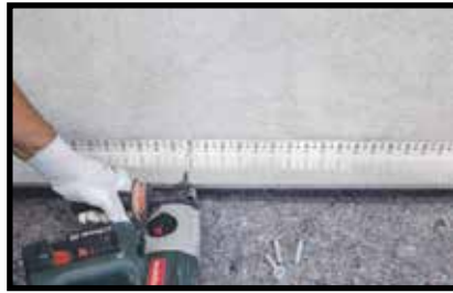
Установка исходных профилей MAPETHERM BA
