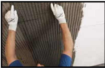
Укладка сетки MAPEGRID G120
