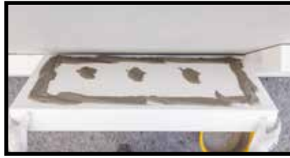
Приклеивание изолирующих плит с помощью зубчатого шпателя в вертикальном направлении
