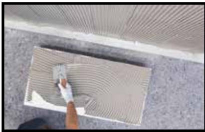
Укладка изолирующих плит с двойным нанесением клея (обратная сторона плиты)
