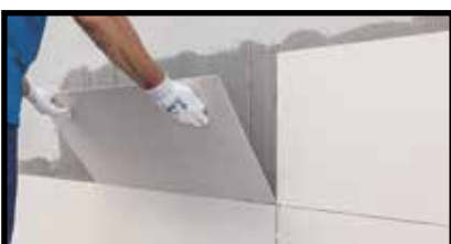
Приклеивание плиты KERLITE
