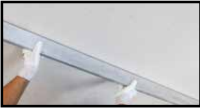
Проверка плоскостности
