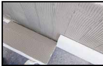
Укладка изолирующих плит с двойным нанесением клея
