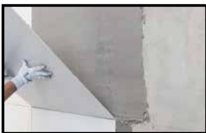
Приклеивание плиты KERLITE
