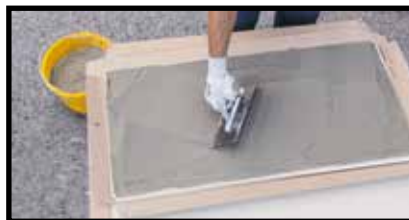
Двойное нанесение (обратная сторона плиты KERLITE)
