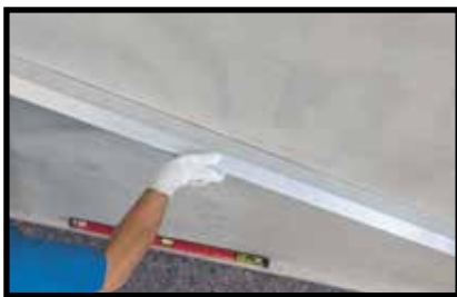
Проверка плоскостности слоя штукатурки
