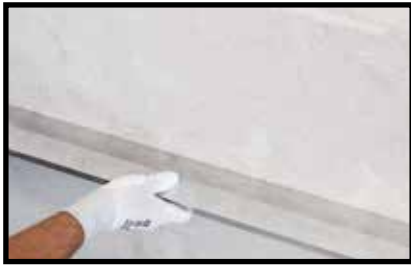
Проверка плоскостности
