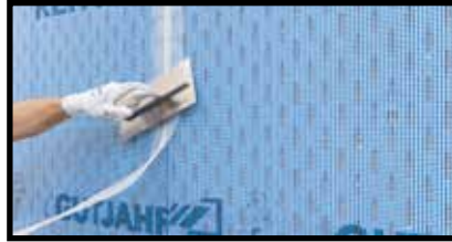
Приклеивание Watec ST — сетки для армирования стыков
