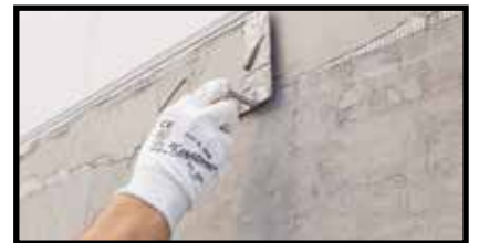
Установка профиля на сетку
