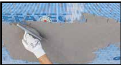
Нанесение штукатурки для заполнения сетки с помощью зубчатого шпателя в вертикальном направлении
