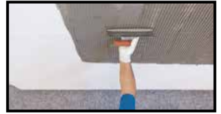
Нанесение клея зубчатым шпателем в вертикальном направлении
