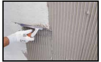
Укладка изолирующих плит с двойным нанесением клея (стена)
