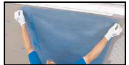
Укладка армирующей сетки CeraVent
