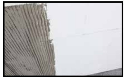
Нанесение первого слоя PLANITOP HDM MAXI
