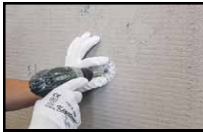
Крепление с помощью монтажного комплекта MAPETERM TILE FIX15
