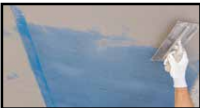
Последнее нанесение штукатурки
