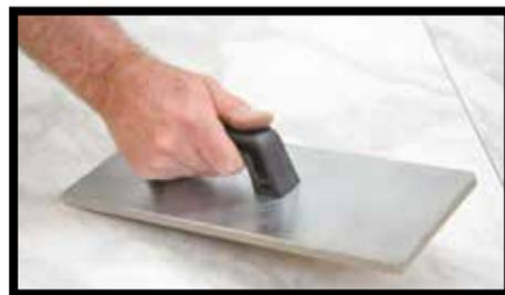
**Рис. 30.** После укладки плитки необходимо обеспечить равномерное распределение клея по всей ее поверхности во избежание образования пустот и пузырьков воздуха. В этих целях используются резиновые кельмы (гладилки) (например, Raimondi 142G).
