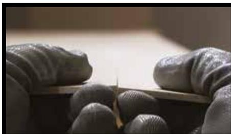
**Рис. 3.** После надреза достаточно слегка надавить на плитку, чтобы разделить обе части.
