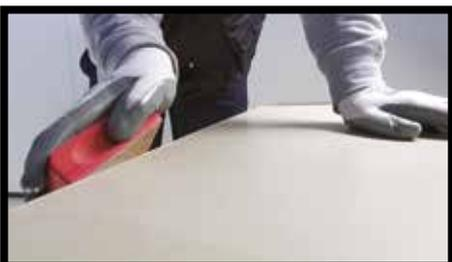
**Рис. 12.** Кромки можно обрабатывать вручную алмазными губками или наждачной бумагой. Провести ими по кромке один раз для сглаживания или несколько раз для получения эффекта скоса.
